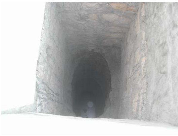
Al Muwaijei Falaj vertical shaft
